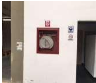
Hidrante en fachada bodega Gabinete contra incendio interno Equipos sistema contra incendio
